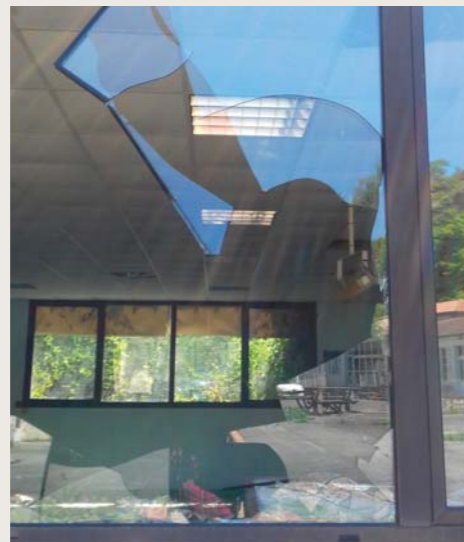
Vandalisme au collège
