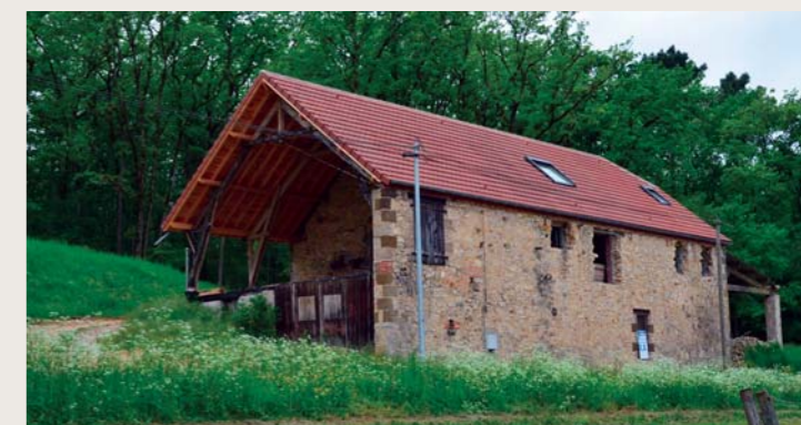
Grange en cours de rénovation pour habitation.
