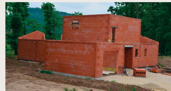
Maison en construction.
